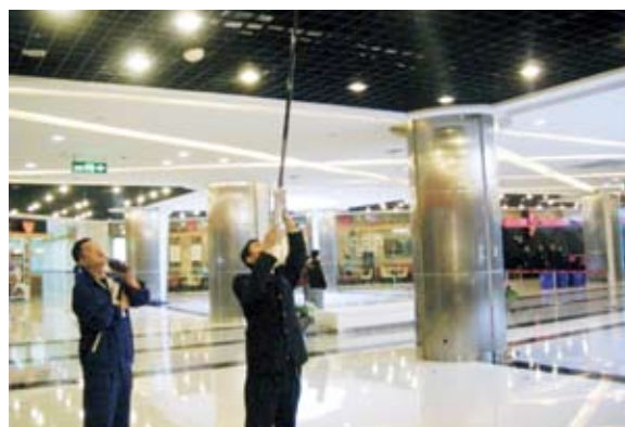
2013年5月3日，合肥包河万达广场工程技术人员进行消防联动测试
